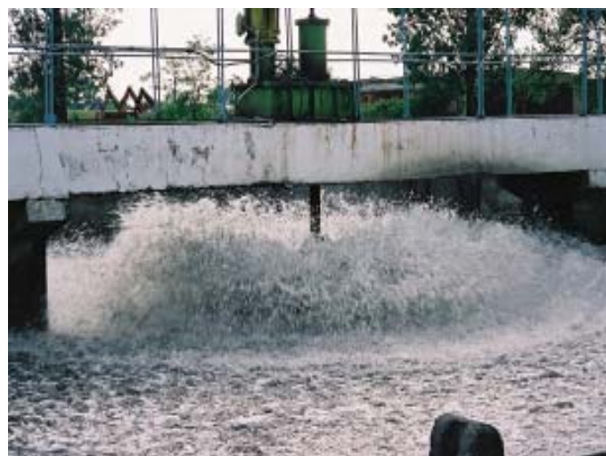
Stația de epurare: sistemul de aerare
