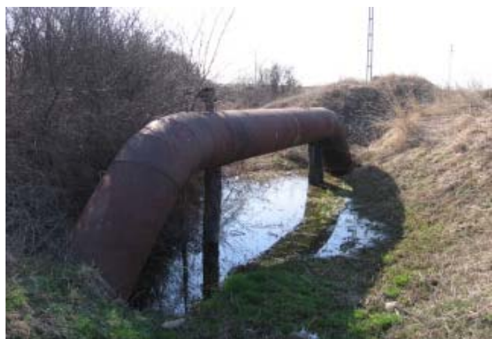
Conducta de aducțiune - supratraversare
