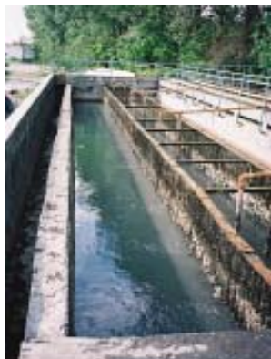
Stația de epurare: separatorul de grăsimi
