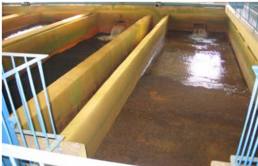
Stația de tratare a apei potabile de la Mărtinești: stația de filtrare
